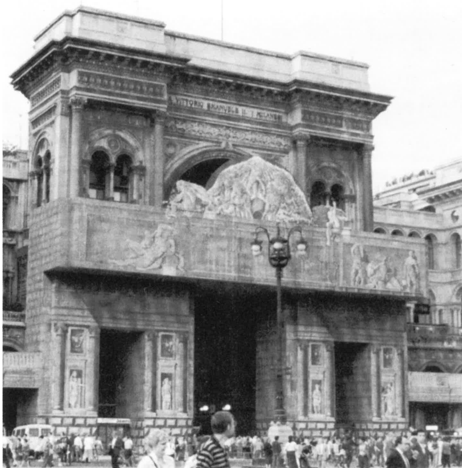
8. Očito je da gradskoj upravi Milana nisu dovoljne jednostavne cijevne konstrukcije, pa restauratorske radove na fasadi Galerije radije pokrivaju mikelandelovskim strukturama, čije transponiranje izaziva nedvojbeni kič učinak, za razliku od provizornog pokrivanja Palače Marino platnom s naslikanim trompe-l'oeil prizorom koji ostavlja ugodan dojam.
